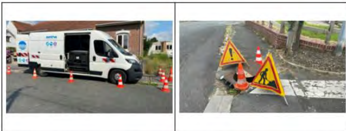
Mise en place de l'unité mobile d'inspection au point d'introduction (compteur abonné) Balisage du point de sortie (regard)
