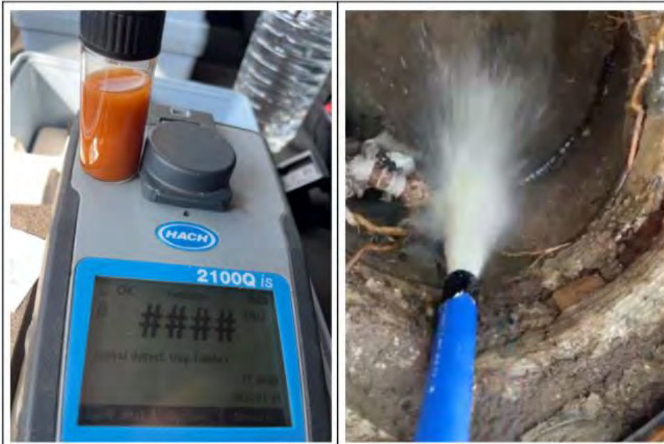
Réalisation des mesures de turbidité par notre turbidimètre Aspect des eaux évacuées après l'intervention
