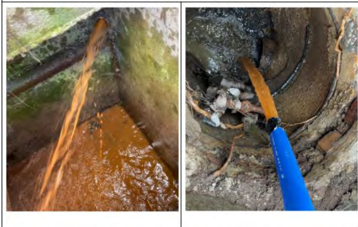
Aspect des eaux évacuées durant l'intervention
