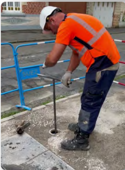
Manutention manuelle d'une vanne
