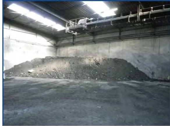
Photo n°2 : Hangar Stockage mâchefers
